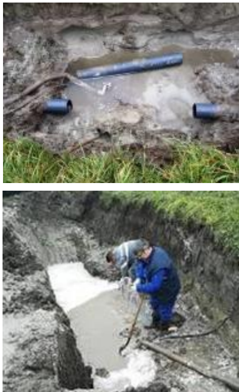
Fig. 1. Burst pipe
