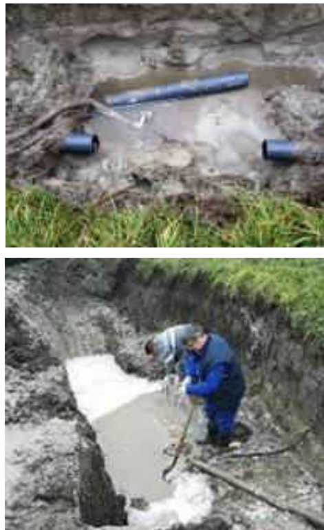
Fig. 1. Burst pipe
